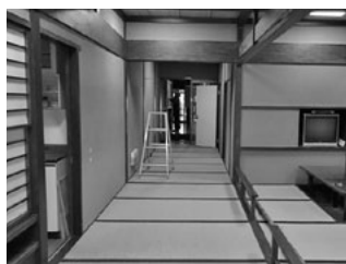
改修工事前のホール
