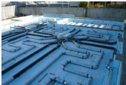
放熱管 100φ スパイラルダクト 配管ピッチ 約500mm
