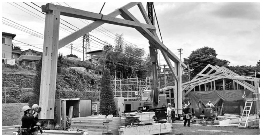
建方が進む「満蒙開拓平和記念館セミナー棟」
