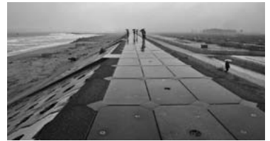
山元町 防潮堤 撮影：丸山幸弘
