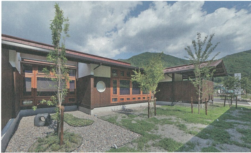
■施設概要 建物用途：診療所 構造・規模：木造平屋建て 延べ床面積：340.25㎡
