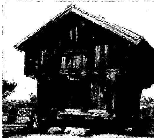
◀一床の紋様とキャンティ工法 開口部はきわめて小さい
