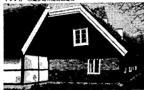
▼レンガ・木造茅葺の混構造建築物
